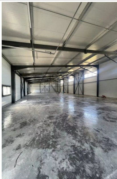
Hangar 4388 Le Teil
